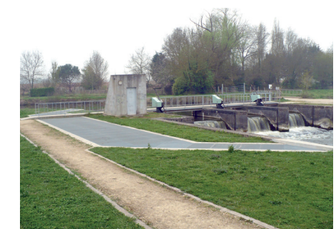
Barrage du Marais Pin
