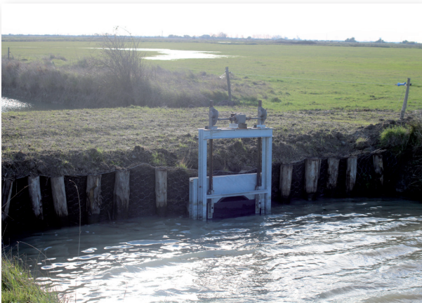
Restauration d'un ouvrage hydraulique
