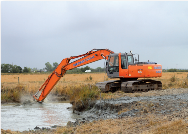
Opération de curage du réseau hydraulique
