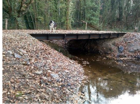
Passerelle métallique pour bétail et engins sur le Pont du Roc'h, à Nostang (Source SMRE)
