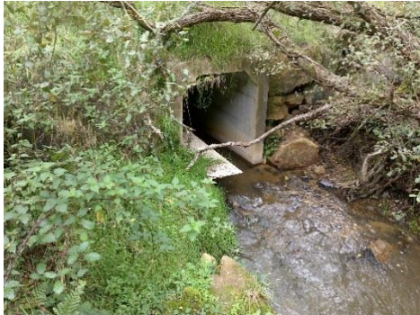
Pont cadre sur le Moulin de Saint Georges, à Merlevenez (Source SMRE)
