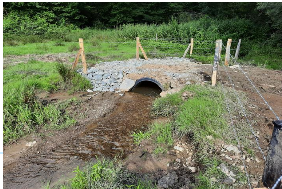
Mises en place de franchissements agricoles : Hydrotube (gauche) Passage à gué sur le Chantegros (Droite)
