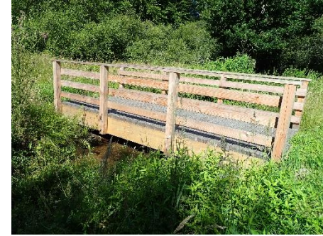
Passerelle en bois pour bétail sur le ruisseau de Listoir, à Languidic (Source SMRE)
