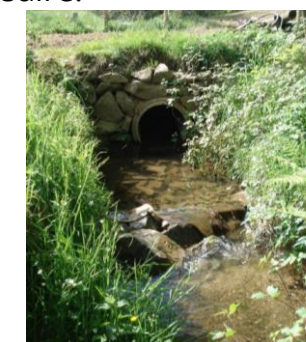
Pré barrage en aval d'une buse (source BV Vilaine)
