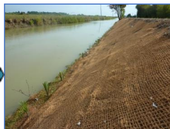
Mise en pente douce avec pose de toile « coco » et plantation
