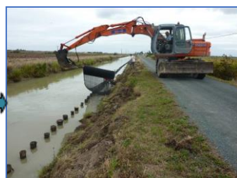
Alignement de pieux et pose du grillage/géotextile
