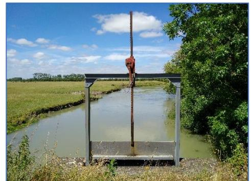
Action envisagée : Aujourd'hui équipé de système de manœuvres manuelles (cric, crémaillère, ...), l'installation d'un automatisme permettrait d'affiner la gestion des niveaux d'eau sur ce secteur sensible (secteur amont proche de la nappe connexe avec risque d'inversion des flux du marais vers la nappe) en coordination avec les ouvrages du camping et des Trois fossés)
