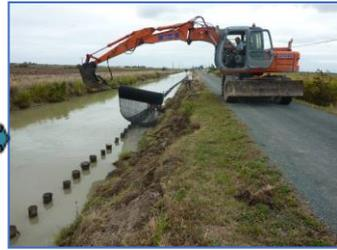
Alignement de pieux et pose du grillage/géotextile
