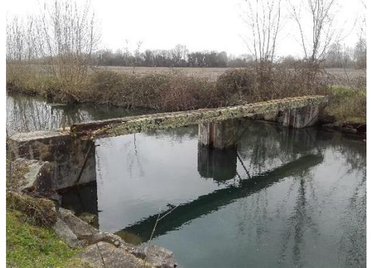
Action envisagée : Fourniture et pose d'un portique, d'une vanne en bois et des systèmes de manœuvres manuelles (cric, crémaillères, ...). L'un des deux pertuis serait condamné, le profil en travers du cours d'eau étant bien inférieur à la largeur actuelle des deux pertuis.
