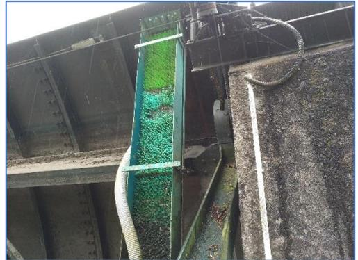
L'ouvrage est équipé de deux rampes à anguilles temporaires, c'est-à-dire qu'elles sont installées sur les vannes au printemps puis démontées avant l'hiver. Cette gestion est coordonnée par le PNR MP depuis 1996. Ces équipements sont aujourd'hui vétustes.
