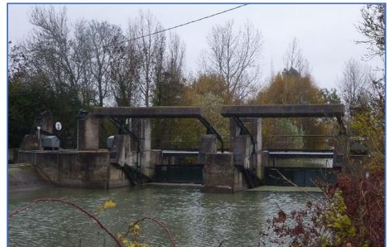
L'ouvrage date des années 1960 avec la spécificité de l'époque où les vannes étaient conçues de façon incurvée avec des contre-poids manœuvrés par des câbles.
